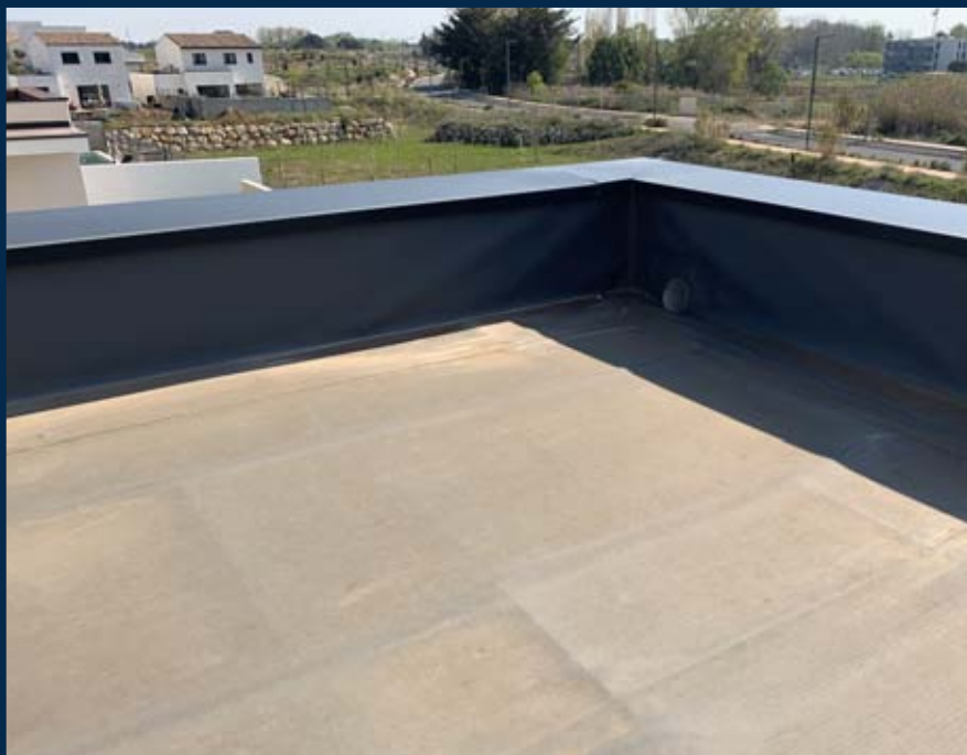
Membrane PVC Thermo soudée
